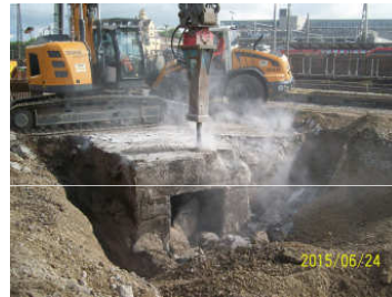
Rückbau des Bunkers, welcher sich als sehr widerstandsfähig erweist (Fotos Stadt Augsburg)
