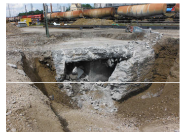
Rückbau des Bunkers, welcher sich als sehr widerstandsfähig erweist (Fotos Stadt Augsburg)
