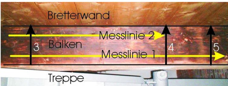
Abbildung 165: Untersicht auf Balken mit Messlinien 1-5
