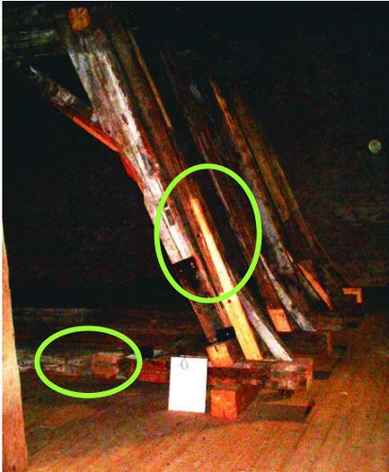
Abbildung 182: Kemptner Dach aus dem 17. Jahrhundert mit zwei Reparaturstellen, an denen Messungen mit Ultraschallecho durchgeführt wurden.
