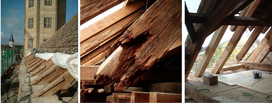
Abbildung 192: Schaden am Dach in Traufbereich durch schadhafte Dachentwässerung
