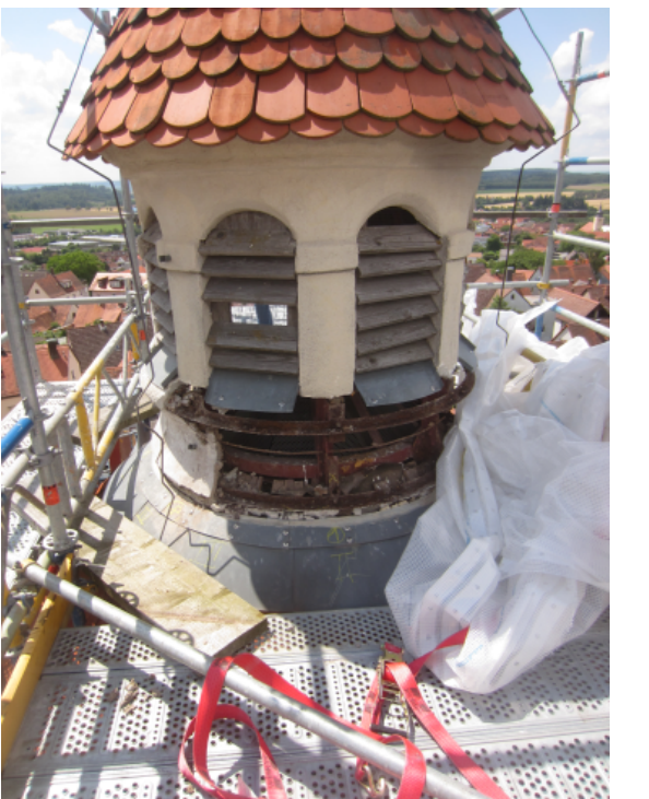
Ausgeprägte Schäden am Stahl – am Turmkopf und der Laterne
