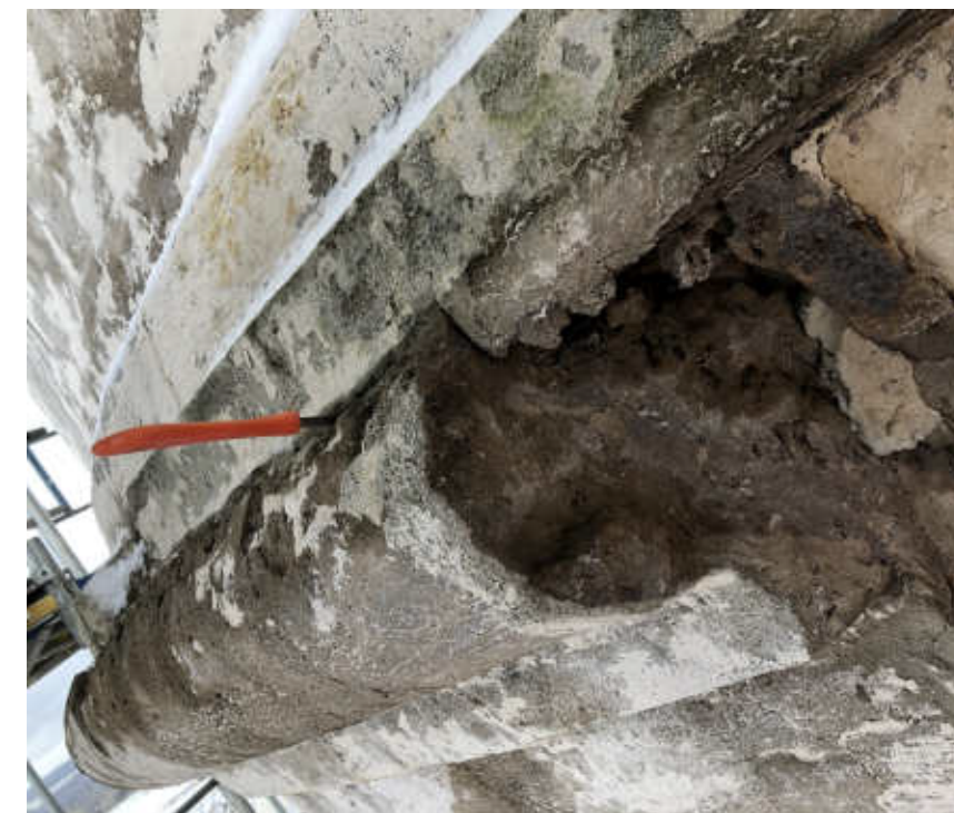
Ausgeprägte Schäden am Stahl – am Turmkopf und der Laterne
