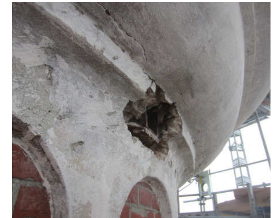
Ausgeprägte Schäden am Stahl – am Turmkopf und der Laterne
